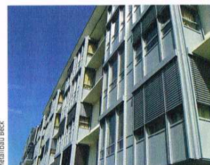
Eine von Metallbau Beck gefertigte Außenfassade am Klinikum Erlenbach
